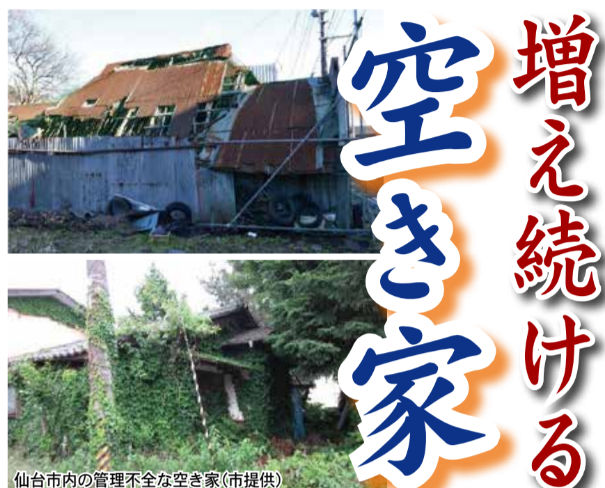
仙台市内の管理不全な空き家(市提供)
